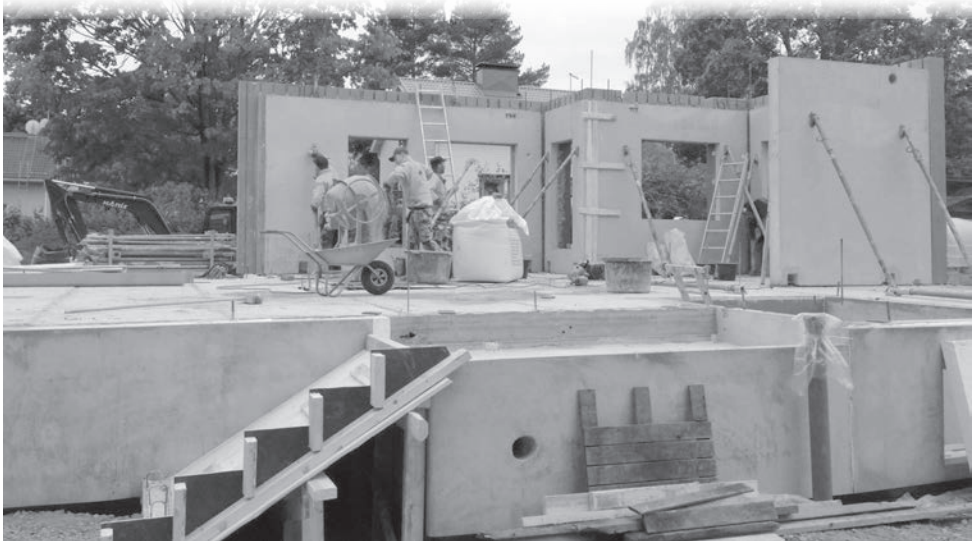
Rungon asennus käynnissä.
