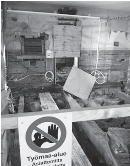
Näkymä keittiön suuntaan ennen remonttia. Kuva: Sanna Puhakka.
