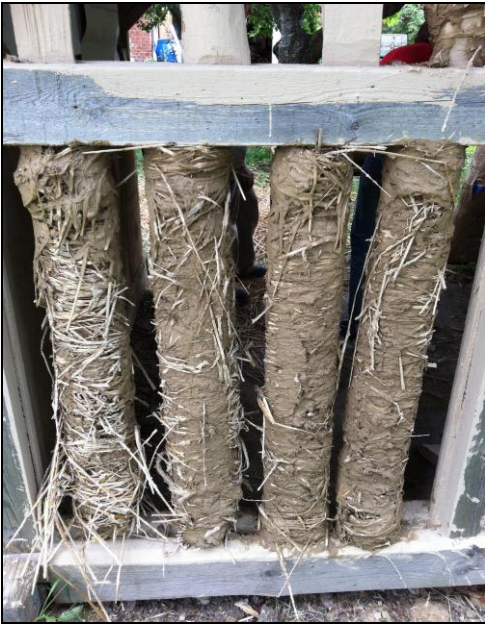
3. valmis seinänpohja savirappaukselle
