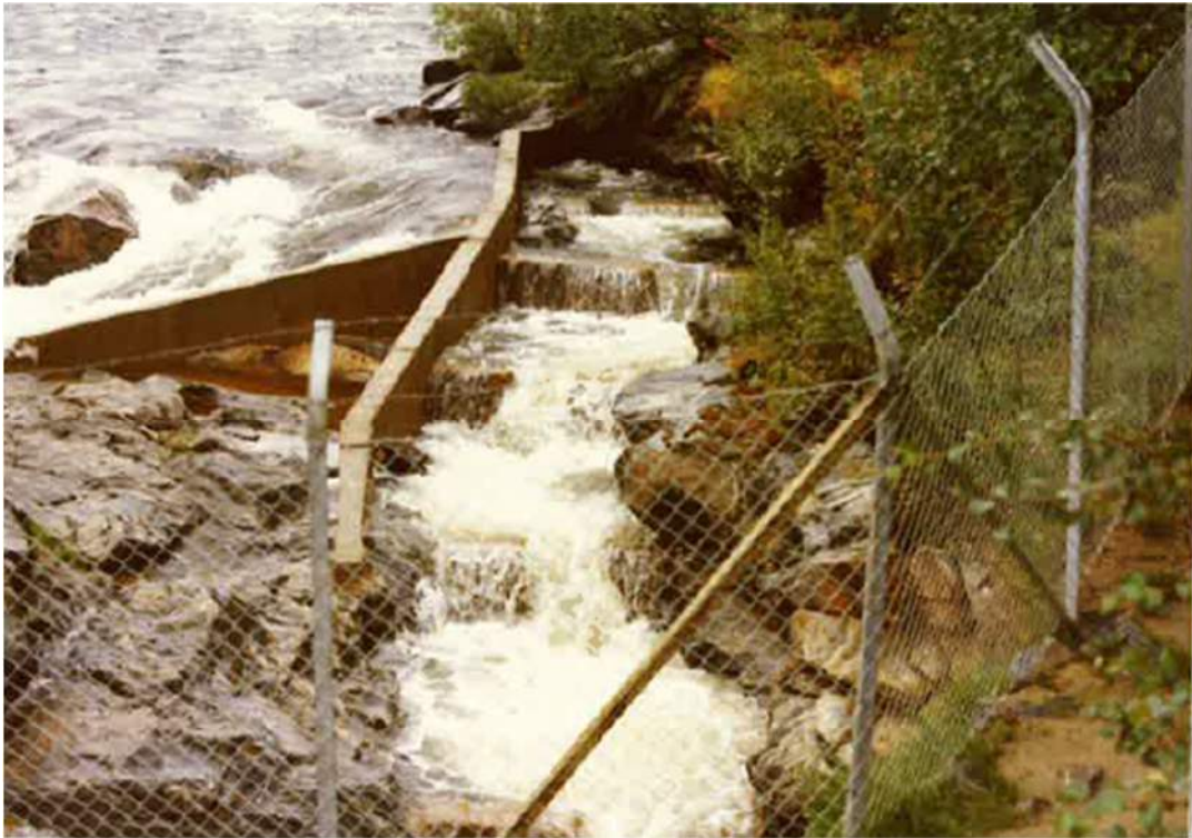
Valokuva 10. Neidenin kolttakönkään kalaporras suoja-aidan rakentamisen ja ensimmäisen peruskorjauksen jälkeen elokuussa vuonna 1974. Valokuva Kiril Sergejeff.
