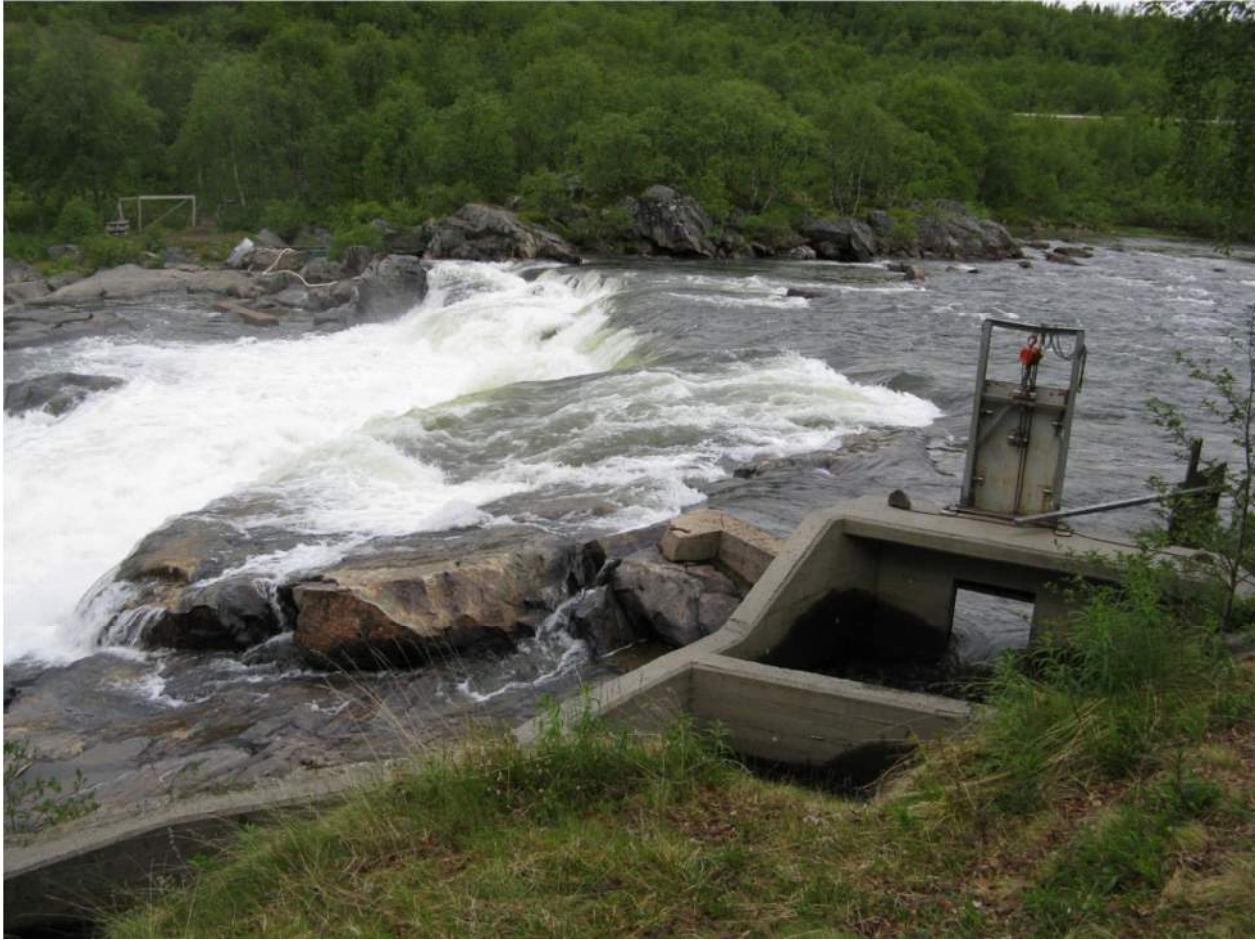
Valokuva 25. Vuoden 2000 syksyllä saatiin kalaportaiden ylimmät kaksi askelmaa valmiiksi ja samalla ulosmenoaukkoon asennettiin kalaportaiden vesimäärää säätelevä mekaaninen luukku. Valokuva Eero Niemelä.
