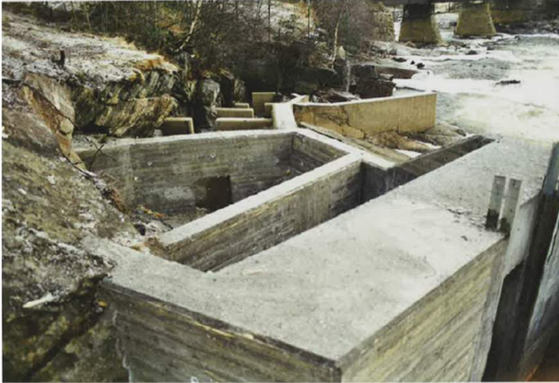
Valokuva 23. Näätämöjoen Kolttakönkään perusteelliset korjaukset tehtiin loppuun vuonna 2000. Portaiden kaksi ylintä askelmaa korjattiin. Porraskaskelmien syvyyttä lisättiin, jotta lohilla olisi mahdollisuus levähdyksiin nousun aikana. Valokuva Kjell Moen.
