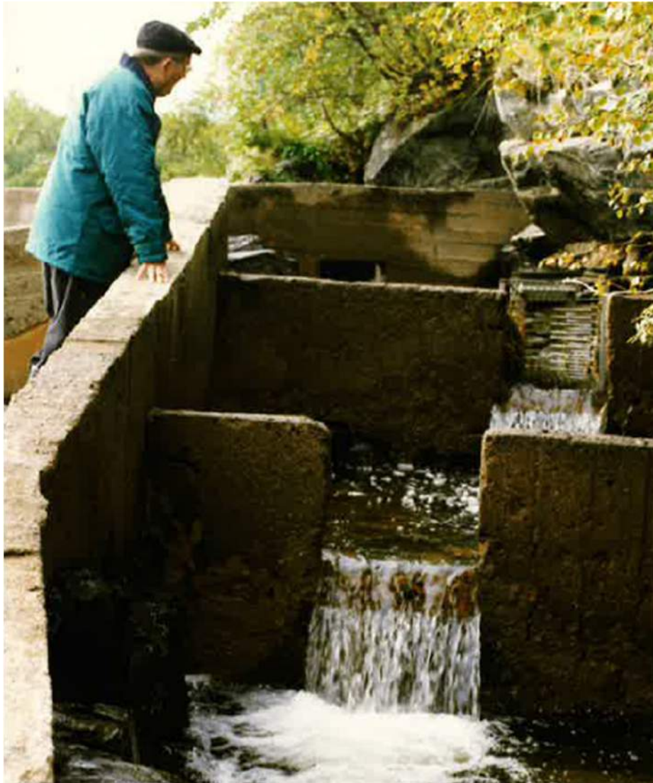
Valokuva 16. Suomalainen kalaportaan tekninen tarkastaja Eero Kajosaari ihmettelee kalaportaan altaiden mataluutta ja arvioi porraskuonon viritetyn mekaanisen kalalaskurin toimintaa. Valokuva Kjell Moen.
