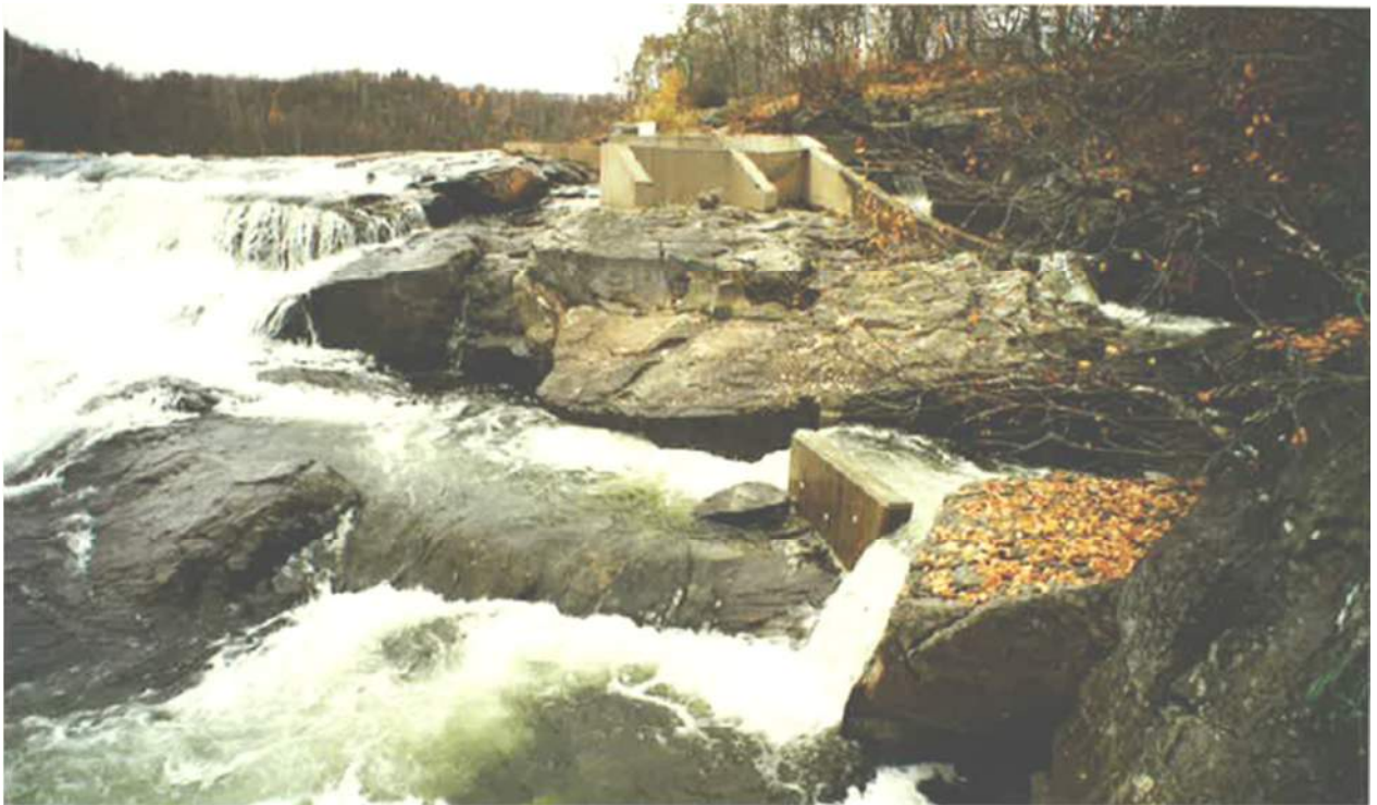
Valokuva 19. Kalaportaan alimman altaan sis antuloaukko 4.10.1997 korjauksen j lkeen. Syksyll  vuonna 1997 portaiden kuuteen alimpaan askelmaan tehtiin uudet betonisein t. Joen virtaama 4.lokakuuta oli selv sti suurempi kuin ylemm ss  24. syyskuuta otetussa kuvassa, mist  johtuen alimman portaan ylivirtausaukosta tulee runsaasti vett . Lohet menev t alimpaan portaaseen p  asiassa varsinaisesta sis antuloaukosta. Virtaaman ollessa joinakin vuosina hein -elokuussa normaalia pienempi lohien on vaikea hakeutua sis antuloaukon kohdalla olevaan joenkohtaan. Valokuva Kjell Moen.
