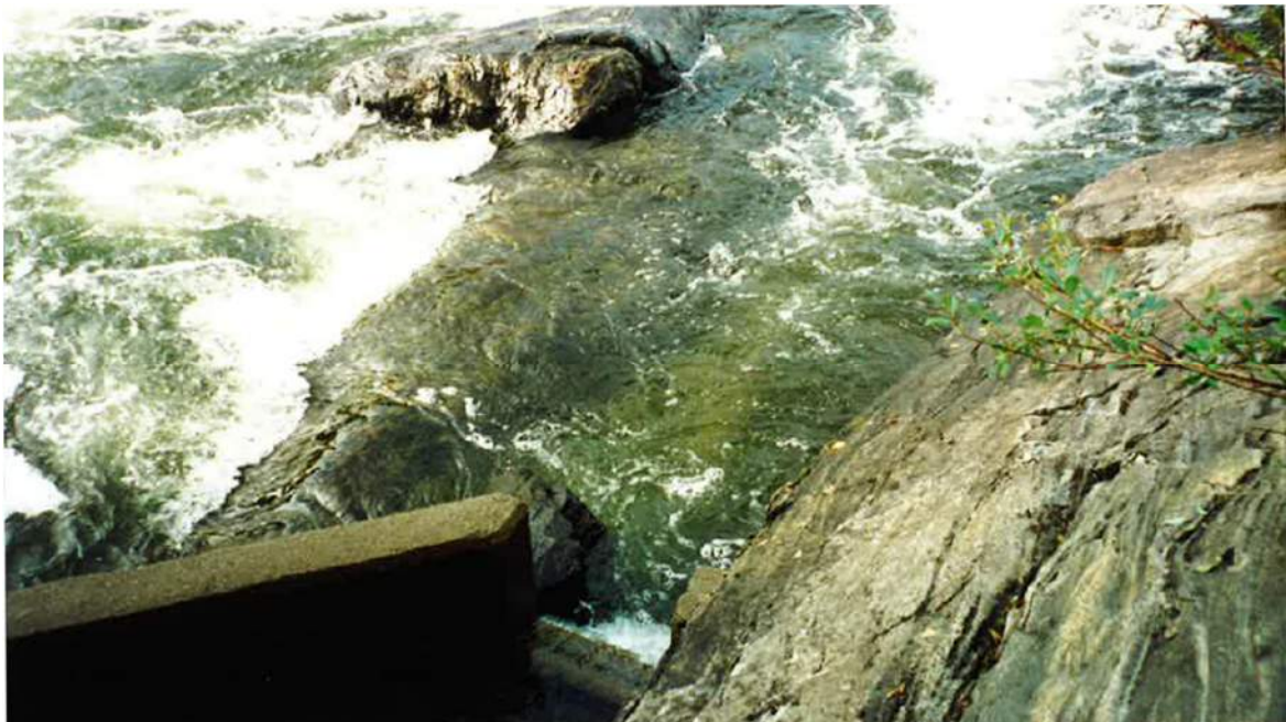
Valokuva 21. Elokuussa vuonna 2000 kalaportaan teknisen tarkastamisen yhteydessä estettiin veden virtaus portaisiin lähes kokonaan. Kuvasta nähdään, että alimman porrasaskelman alapuolella (kuvan oikeassa reunassa kallion kupeessa) oleva luonnontilainen monttu ei ole kovin syvä eikä laaja. Näin vähäisellä Näätämojoen virtaamalla lohien nousuhalukkuus ylempään lepomonttuun kuvan keskellä
