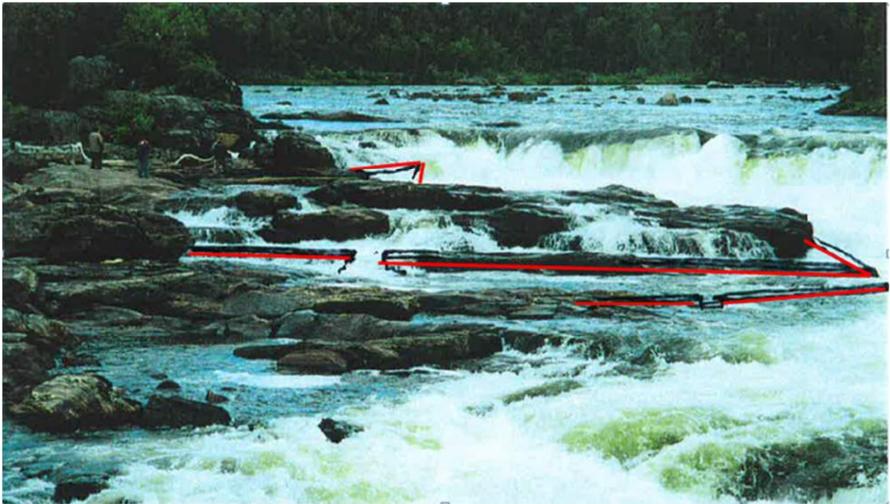
Valokuva 32. Kuva ehdotuksesta lohiportaiden rakentamiseksi joen eteläiselle reunalle Kolttaköngkään alapuolelle ja käpälänuottakuopan viereen. Valokuva Carnie Consultancy -konsulttiyhtiön laatimasta raportista. Valokuvassa on vahvistettu punaisella värillä esitettyjä altaiden reunoja.
