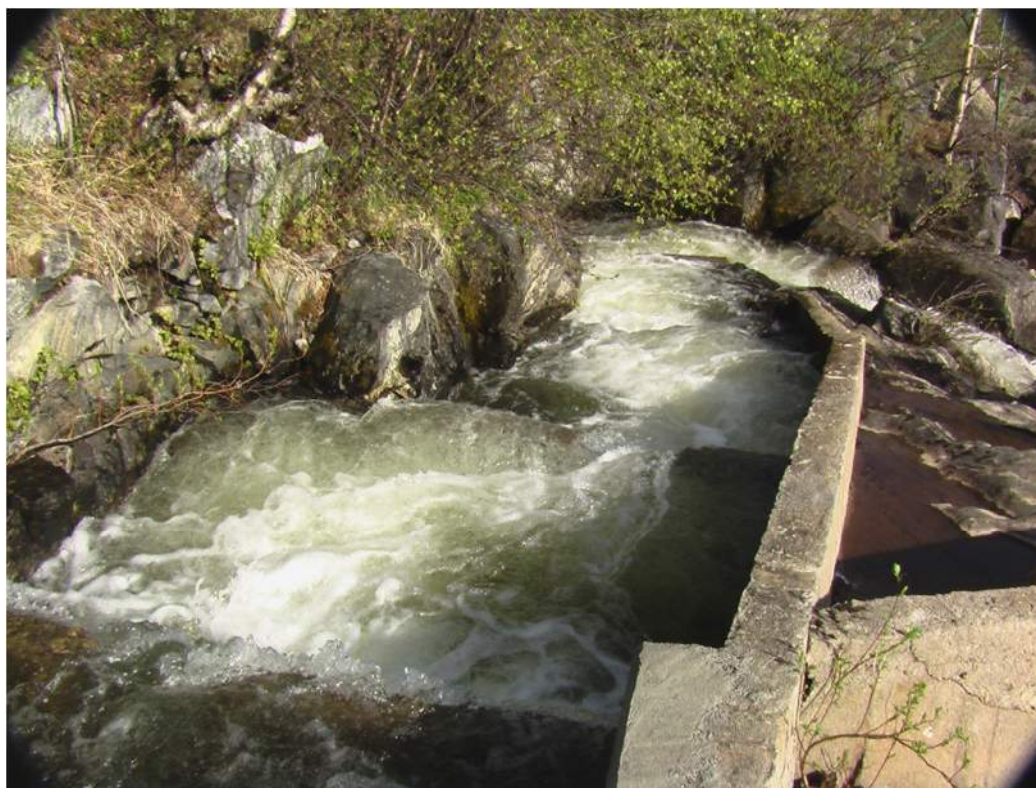
Valokuva 49. Liian suuri virtaama kalaportaassa vaikeuttaa lohien vaellusta ylävirtaan. Valokuva Eero Niemelä.
