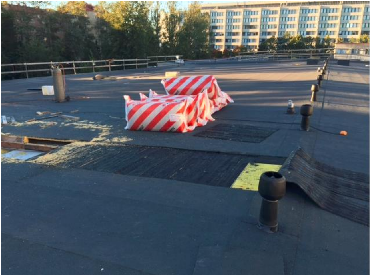
Avattu katto harjalta kuvattuna.
