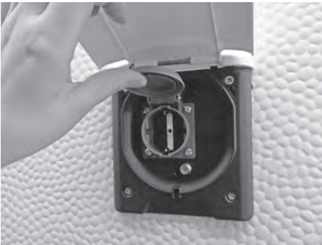
Etuteltan ulkopistorasia, sisältää antenniliitännän
