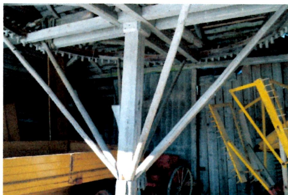
Hevoskiertolaitteen yläosassa on ratas, josta hevosen pyörittämänä voima siirtyi edelleen puinnin avuksi.
